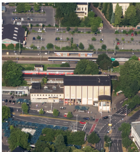
Luftbildaufnahme vom Rheydter Hauptbahnhof.
