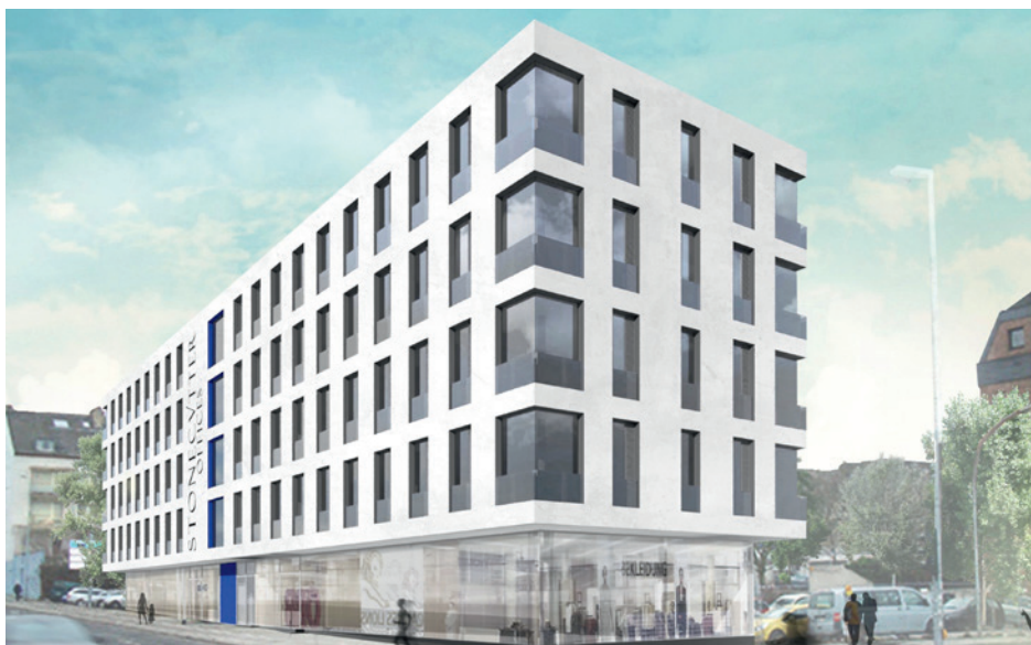
Der neue Bürokomplex an der Steinmetzstraße.
