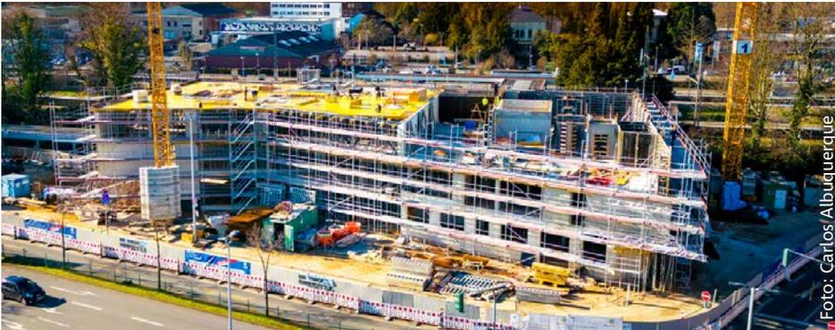
Noch ist alles im Rohbau. Schon jetzt ist der dreigeschossige Baukörper zu erkennen. Er erhält ein Staffelgeschoss. In der Mitte gibt's einen barrierefreien Durchgang zu den Gleisen und der zentralen Bahnhofshalle.
