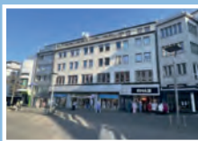
Wohn- und Geschäftshaus MG - City
