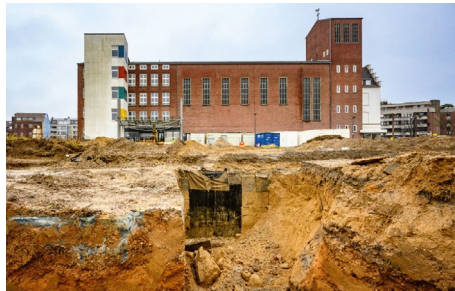
Der schadstoffbelastete Bunker auf den Maria-Hilf-Terrassen muss weichen. FOTO: EWMG
