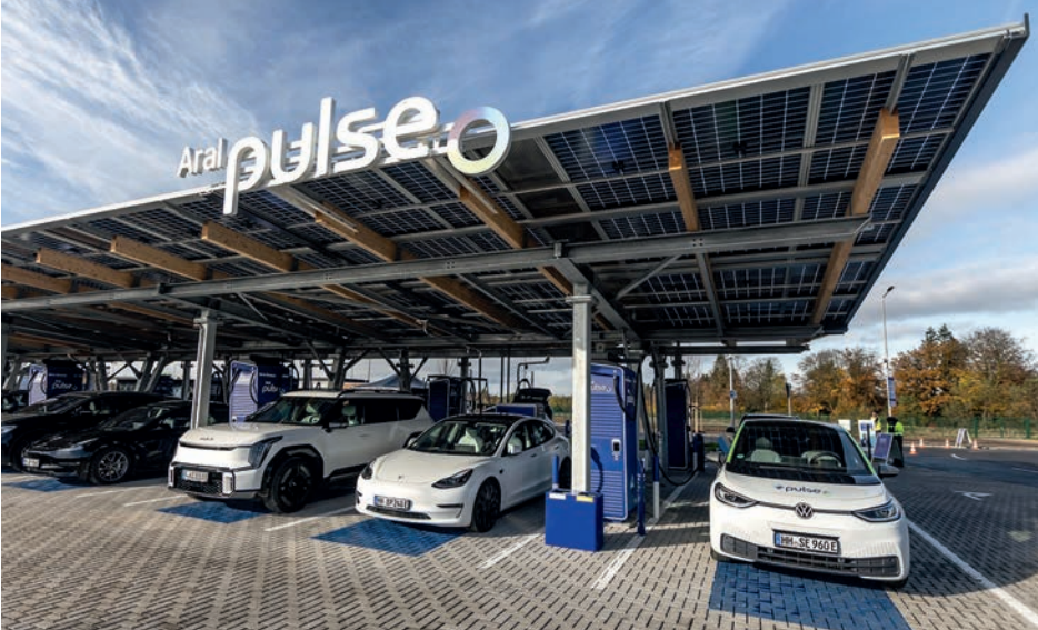
Der neue Ladepark befindet sich an der Belgrader Straße im Nordpark, unweit des Borussia-Parks. Die 28 Ladebuchten sind überdacht, die Dächer wiederum mit Photovoltaikanlagen bestückt. FOTO: ARAL AG
