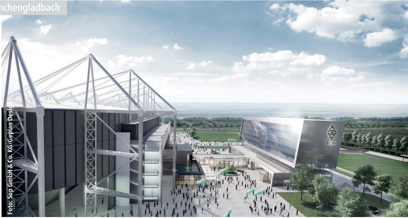
Direkt am Stadion von Borussia Mönchengladbach entsteht ein Hotel mit 132 Zimmern.
